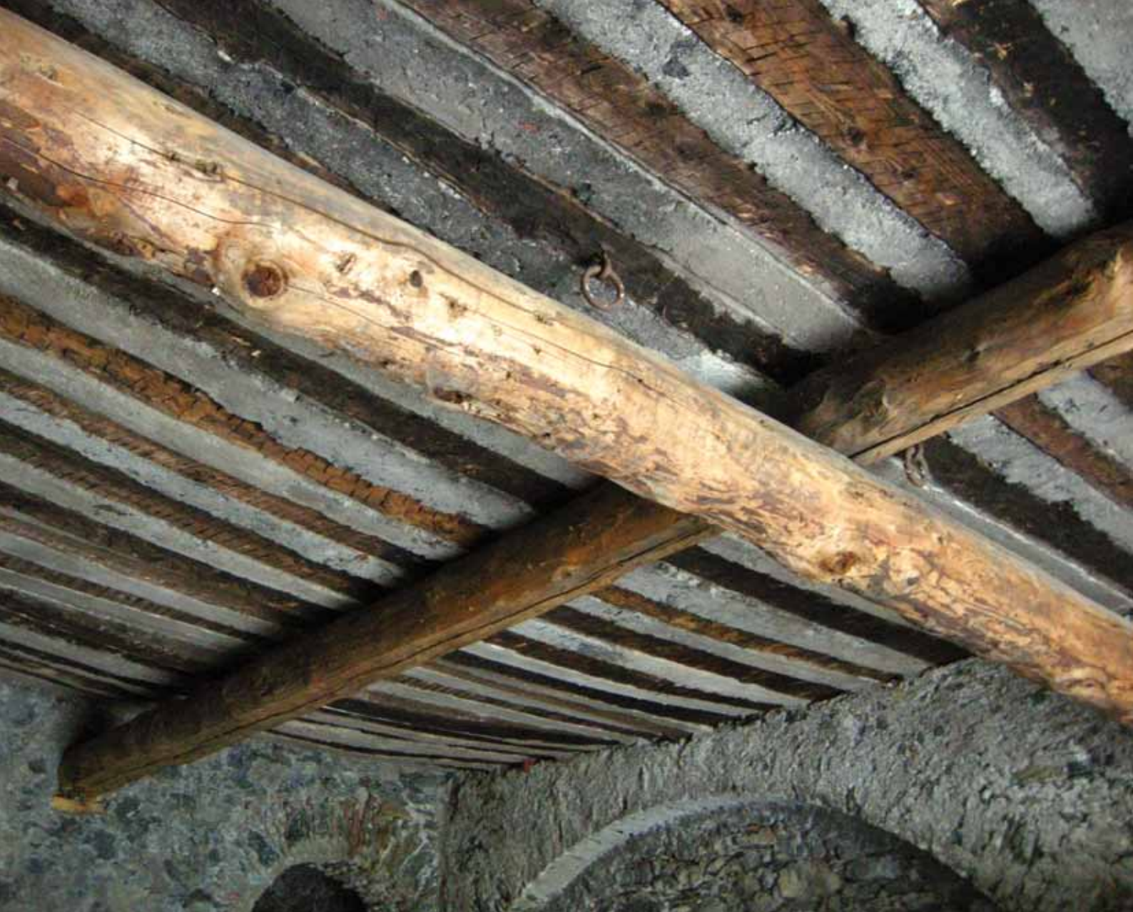
Un caratteristico solaio a “voltapiana” recuperato.
