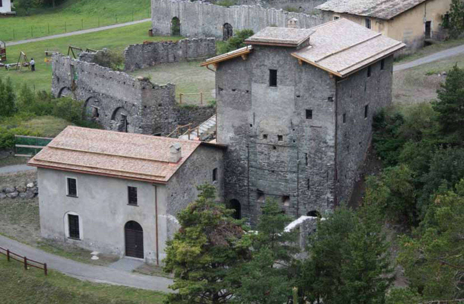
L'altoforno e la "casa del maestro del forno" dopo i restauri.
